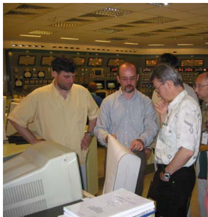
Sodelavci odseka F8 med opravljanjem zagonskih testov v NEK.
