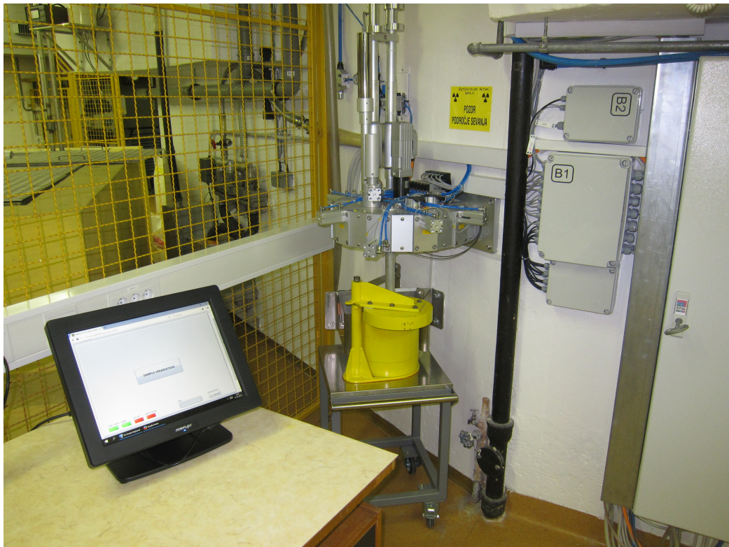
Slika 6.1: Fotografija novega sistema standardne pnevmatske pošte na reaktorju TRIGA.
